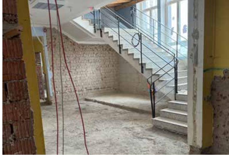
Die Treppenhäuser wurden staubdicht zum EG verschlossen, sodass Putz, Böden und Zwischenwände entfernt werden konnten.
