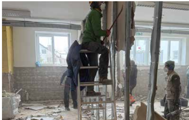
In Handarbeit wurden allein in den ersten 4 Arbeitstagen 62 m 3 Bauschutt aus dem Keller geräumt.
