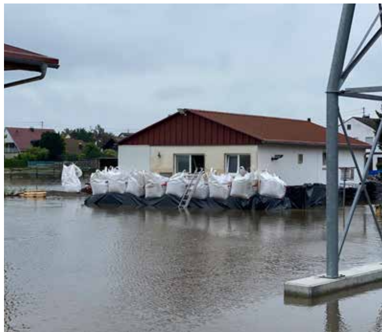
Das Vakuumpumpenhaus lief trotz aller Sicherungsmaßnahmen voll Wasser.
