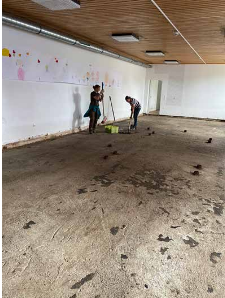
Der Mehrzweckraum der Schule wurde von Freiwilligen nahezu entkernt.
